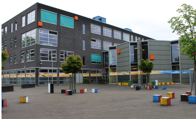
Blauwe centrale luchtbehandelingskasten op het dak
